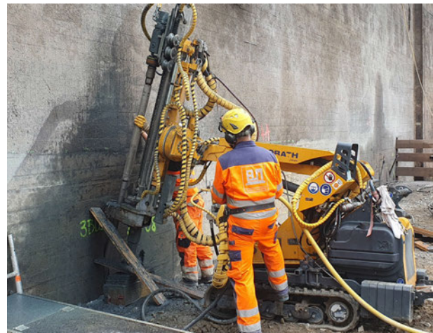
Abb. 5: Herstellung des Dichtungsschleiers an der Wasserseite der Staumauer
