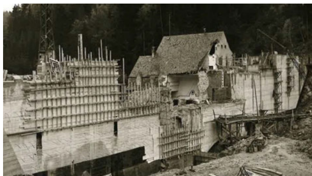
Abb. 1: Ansicht der Wasserseite während des Umbaus 1954/1955 [EDEG]
